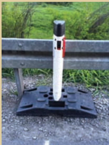
Smerokaz sa ugrađenim komponentama opreme, smešten u bankini puta
