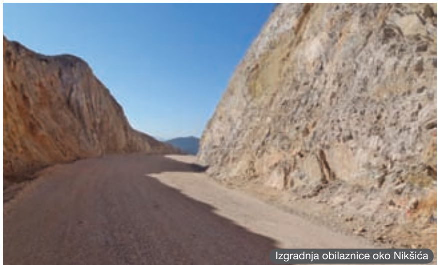
Izgradnja obilaznice oko Nikšića
