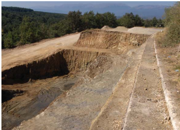
Slika 4. Građevinski radovi na putu M-5
