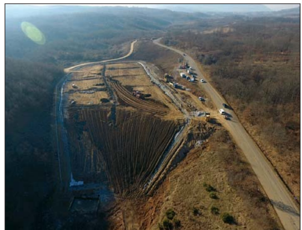
Situacija poslije sanacije
