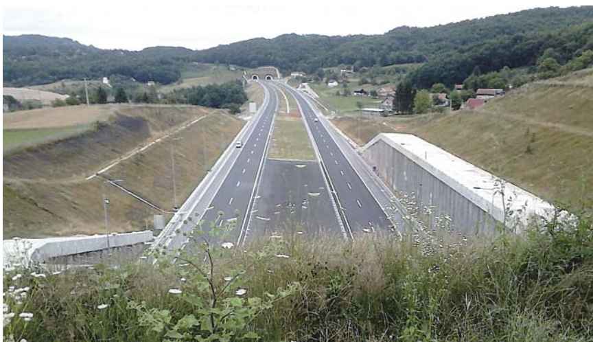
Geotehnički nadzor na dionici Vlakovo - Lepenica, zaštita ulaznog portala tunela Igman
