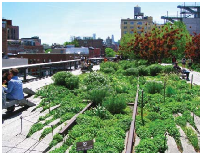
Postojeće železničke šine su sačuvane tokom rekonstrukcije, kako bi bile uklopljene u nove trotoare i zelenilo
