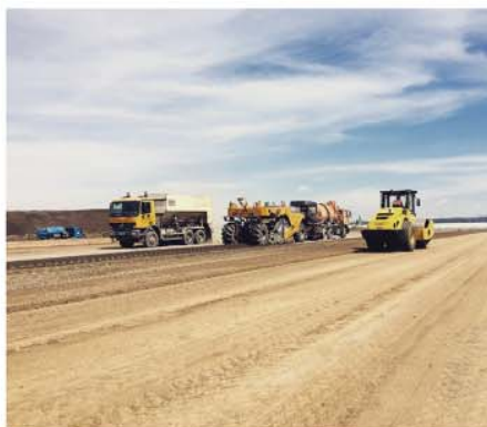
ViaCalco proizvod, vezivo na bazi kreča – u veoma kratkom roku, svojom reaktivnošću postiže značajne rezultate, te dugoročno utiče na ključne parametre samog zemljišta.
