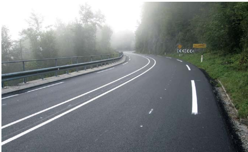
Slika 5. Probna SER dionica u Sloveniji tokom gradnje
