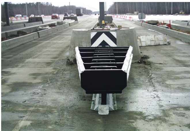
Ublaživač za brzine od 80 km/h za naplatne stanice; trapezoidni
