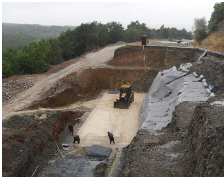
Slika 5. Građevinski radovi na putu M-5
