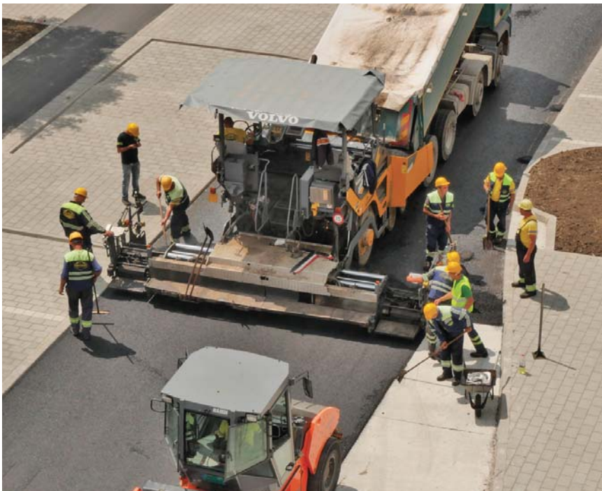
Asfaltiranje ulice Cara Lazara u Futogu
