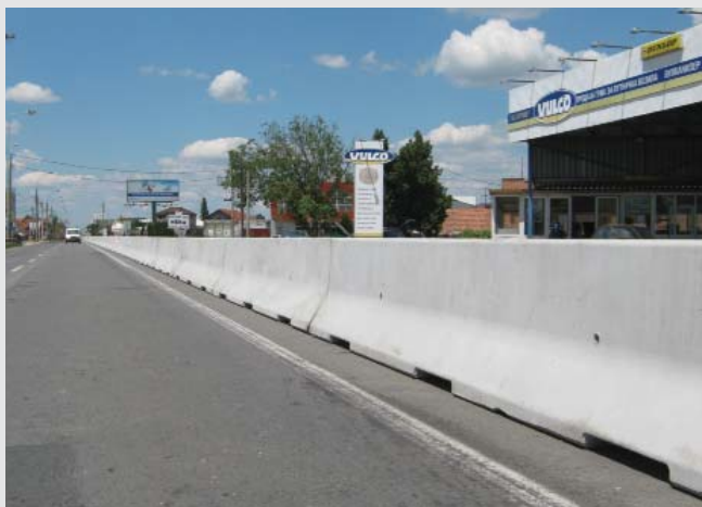
Zrenjaninski put, Beograd, Sistem DELTABLOC® DB 80 H1/W4
