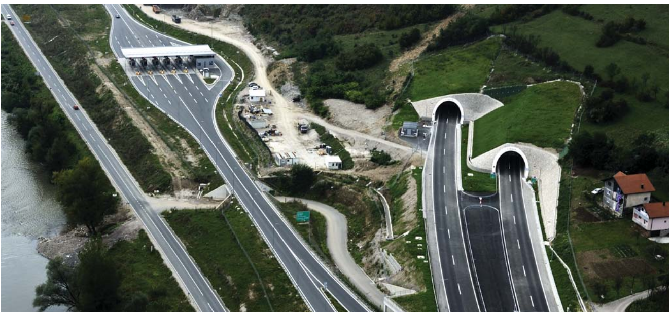
Tunel 1. mart - južni portal, na dionici Gorica - Lašva
