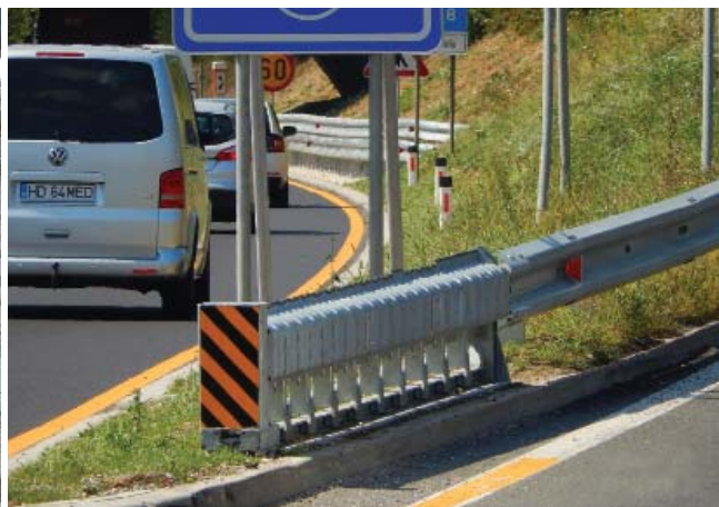
Početna konstrukcija odbojne ograde - deluje apsorbirajuće, preusmeravajuće i obostrano (zamena za ublaživač)
