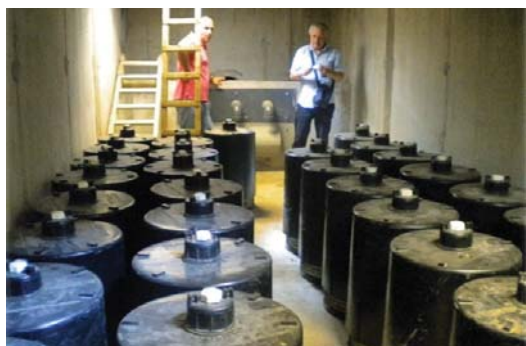
Slika 2. Filtrirana voda (Stormfilteri - levo) se izliva u betonsku retenziju (desno) radi ublažavanja maksimalnih oticaja pre infiltriranja u zemljište ispod retenzije i priobalje reke Save kao izvorište
