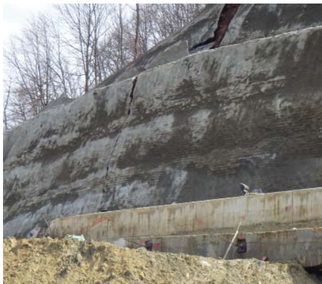
Slika 5. Izgled torkretiranog zida u fazi izgradnje
