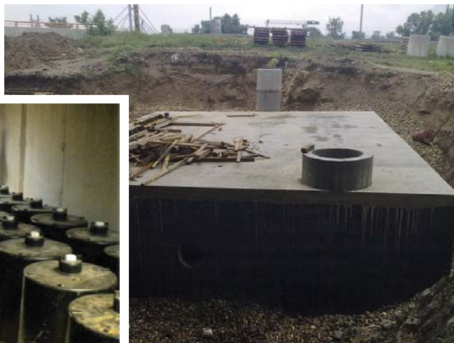
Slika 2. Filtrirana voda (Stormfilteri - levo) se izliva u betonsku retenziju (desno) radi ublažavanja maksimalnih oticaja pre infiltriranja u zemljište ispod retenzije i priobalje reke Save kao izvorište
