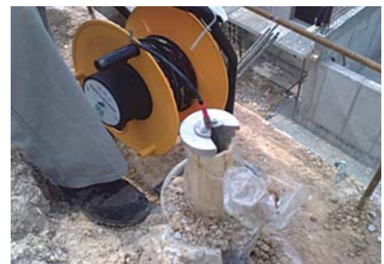
Monitoring padina, usjeka, potpornih konstrukcija
