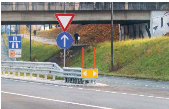
Zbog potrebe za što više slobodnog prostora na uključenju na obilaznicu, upotrebljen je ublaživač za brzinu od 100 km/h dugačak tek 470 cm
