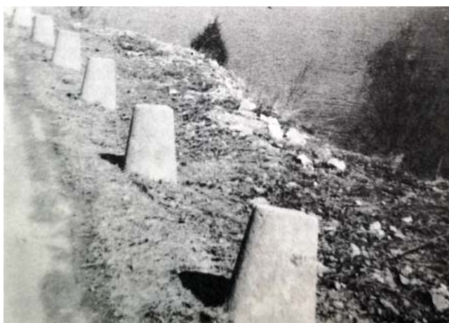
Sl. 3 – Postojeći kolobrani na putu pored Zlatarskog jezera ne mogu uvek da zadrže vozilo u slučaju skretanja
