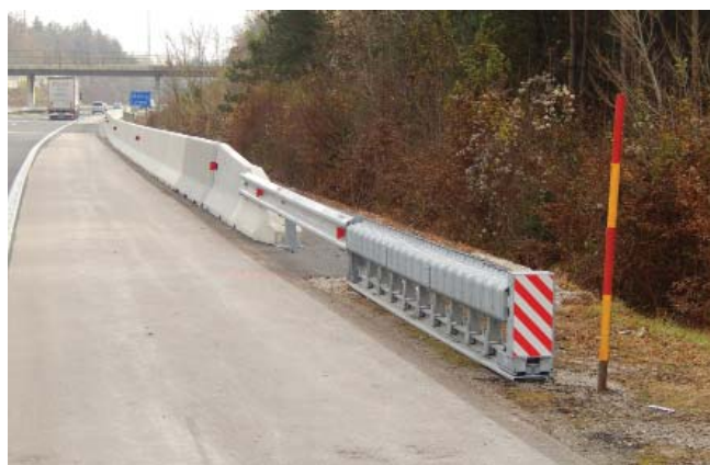
Početna konstrukcija betonske zaštitne ograde zaštićena protiv katapultiranja vozila
