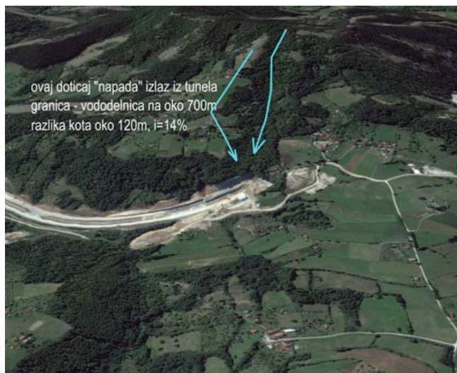
Slika 2. Predeo na kome se gradi autoput i ulazak u tunel Šarani sa prirodnim putevima površinskog oticaja pri pojavi padavina ka budućem tunelu
