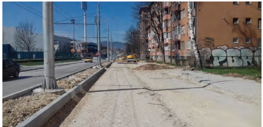
Slika 9. Izgradnja 2. dionice Južne longitudinalne
