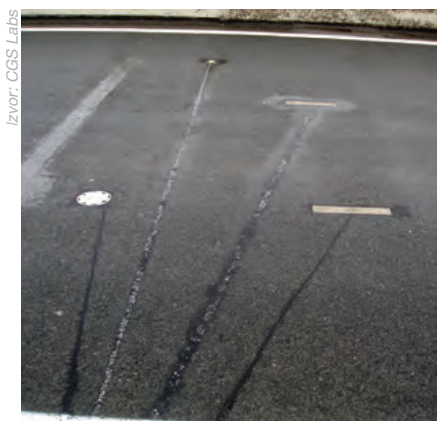
Putni senzori ugrađeni u površinu puta
