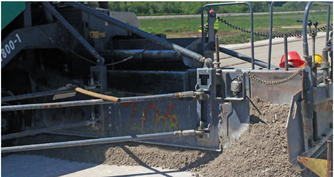
Slika gore: Razastiranje mešavine na pripremljenu podlogu, Koridor X
