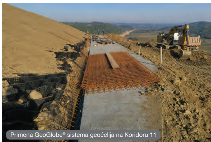
Primena GeoGlobe® sistema geoćelija na kosinama pored puta
