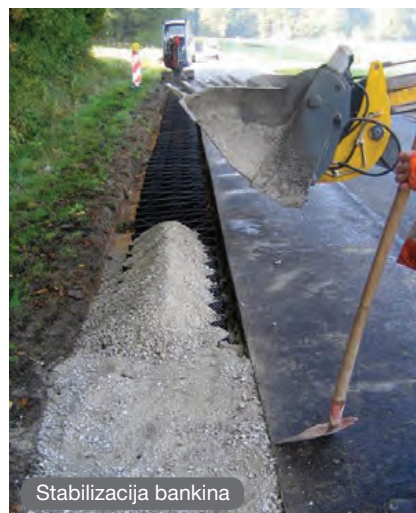
Primena GeoGlobe® sistema geoćelija na Koridoru 11
