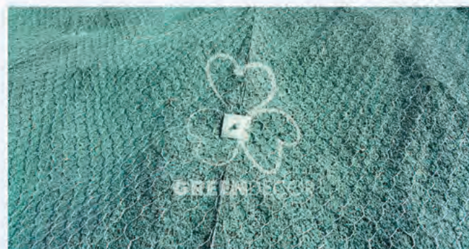
Neposredno nakon izvođenja radova
