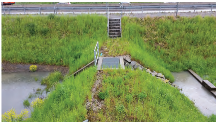
Sl. 4 Specijalna armirano-betonska konstrukcija tzv. monah (Mönch) za vrijeme jake kiše [foto: autor]
