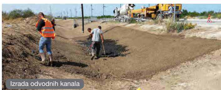
Stabilizacija puta lokalno raspoloživim materijalom
