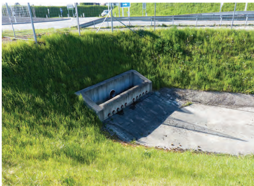
Sl. 2 Armirano-betonsko korito bazena za skupljanje grubog materijala [foto: autor]
