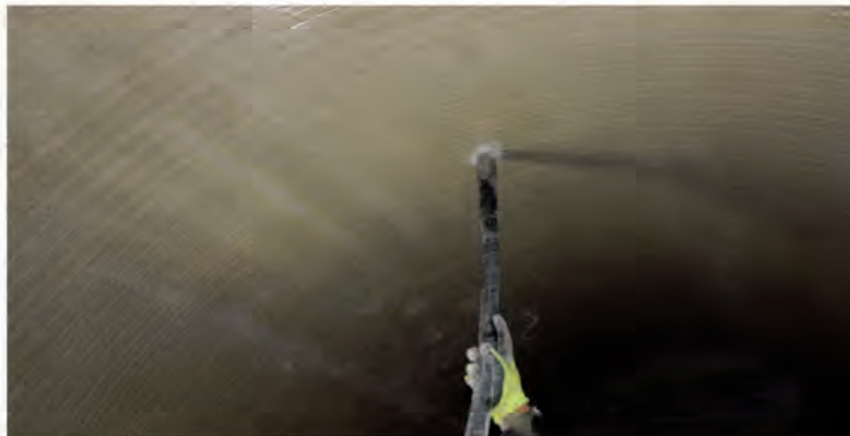
Projekt: Izgradnja male hidroelektrane Medna u Ribniku (Mrkonjić Grad, BIH) Izvođač: Građevinsko preduzeće „Vranica BL” d.o.o. Banja Luka
