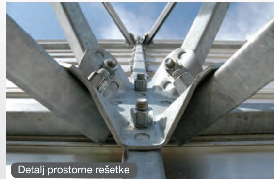
Prostorna rešetka na nadstrešnici
