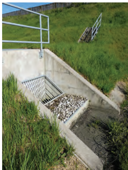
Sl. 7 Monah (Mönch) sa armirano-betonskim zidom za poniranje (Tauchwand) [foto: autor]
