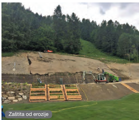
Primena GeoGlobe® sistema geoćelija na Koridoru 11
