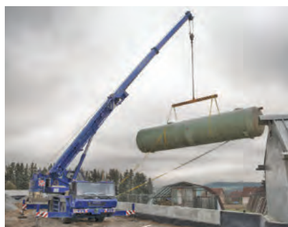
ACO GRP protivpožarni rezervoar od 72 m 3
