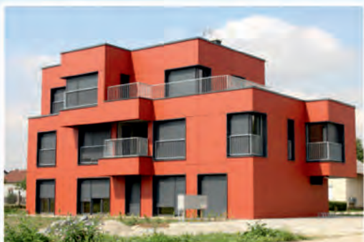
PRVA ECO SANDWICH KUĆA Koprivnica
