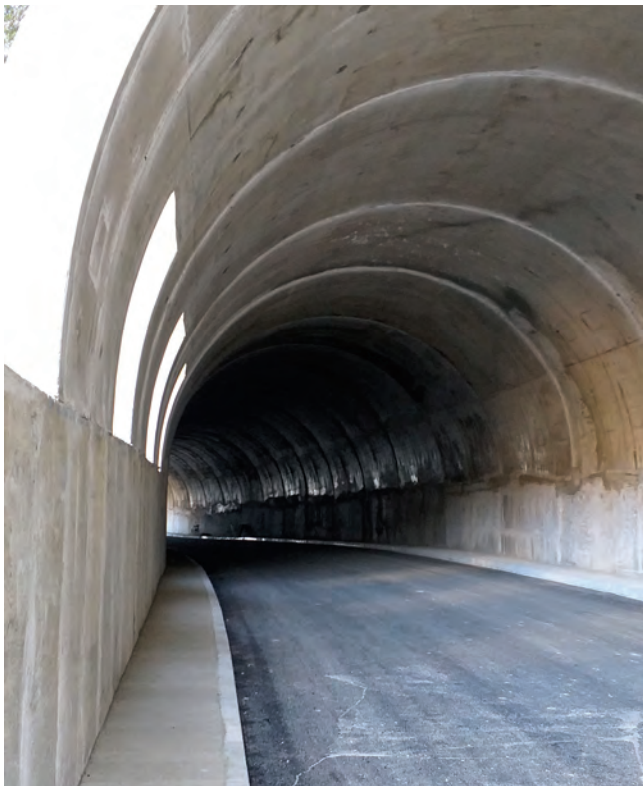
Slike 6. i 7. Portal ulazne galerije i unutrašnjost izlazne galerije i tunela u završnoj fazi izgradnje
