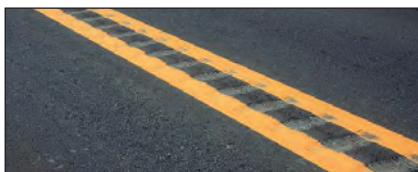
Slika 16. Rebrasta površina optički i fizički (tresenje) upozorava vozača
