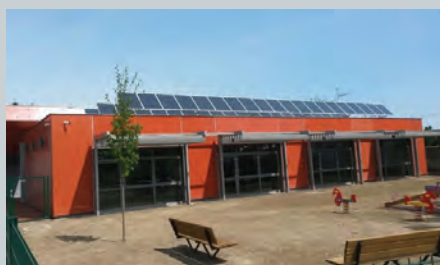
Slika 10: Predgotovljeni fasadni paneli razvijeni u projektu ECO-SANDWICH
