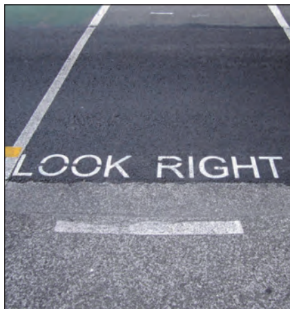
Slika 10. Upozoravajuća horizontalna signalizacija na pešačkom prelazu
