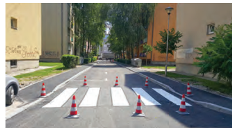
Sanacija ulice Meše Selimovića; projektant: Planinvest d.o.o. Brčko
