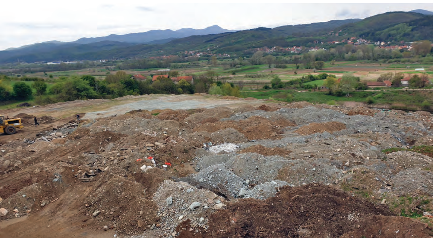
Slika 3. Neadekvatno upravljanje građevinskim otpadom, nedostatak razvrstavanja otpada
