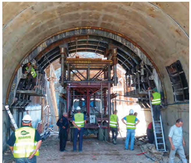
Slika 9. Uklanjanje oplate po kampadama
