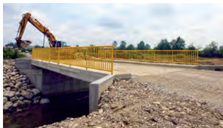
Izgradnja mosta u Pelagičevu; projektant: Planinvest d.o.o. Brčko
