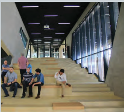
Slika 6: Stepenište od pranog betona (gore) i unutarnje stepenište od brušenog žutog betona na GF Sveučilišta u Osijeku
