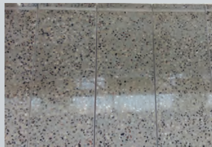
Slika 4: Izgled predgotovljenih betonskih elemenata sa završnom brušenom obradom
