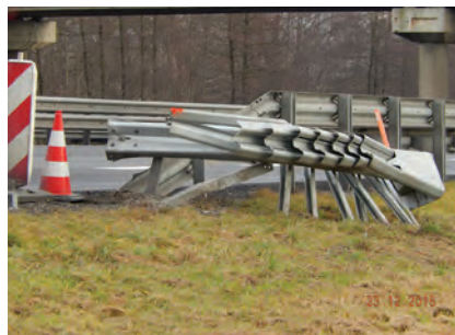
Klasični "riblji rep" probada karoseriju i prouzrokuje nepredvidive posledice kod prodora elemenata ograde kroz putničku kabinu
