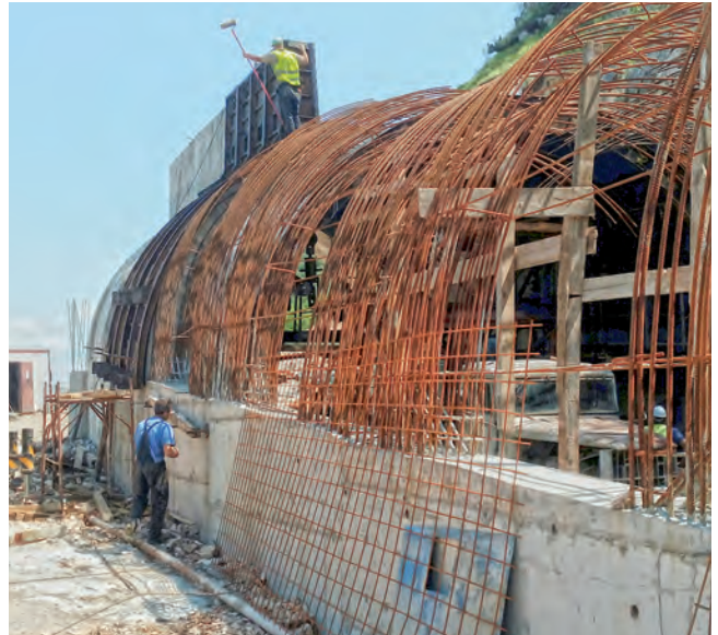
Slika 8. Postavljanje oplate po kampadama
