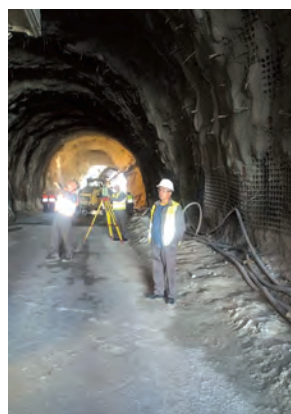
Slika 10. Izrada hidroizolacije tunela „Klezna“
