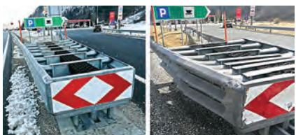
Ublaživač SMA 100W, tek godinu i par meseci nakon ugradnje, odlično je obavio svoju funkciju. Samo je materijalna šteta bila u pitanju.
