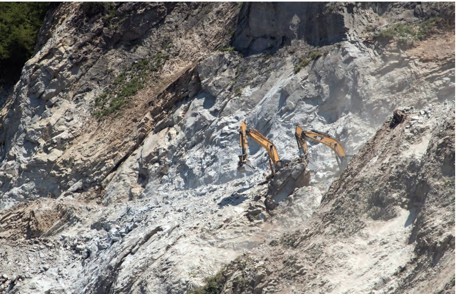
Slika 4: Građevinski radovi - iskop; izvođenje u nepristupačnim terenima stvara višak zemlje iz iskopa
