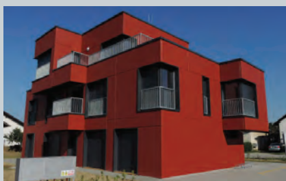
Slika 10: Predgotovljeni fasadni paneli razvijeni u projektu ECO-SANDWICH
