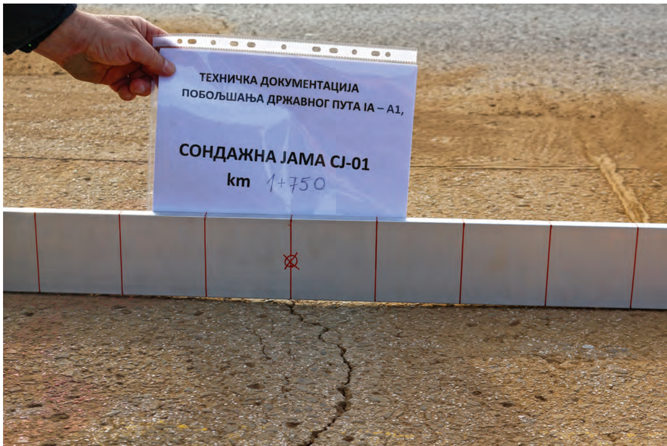
Slika 6. Obostrana deformacija na pukotini
