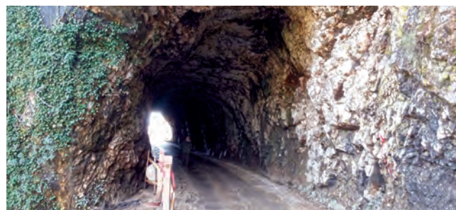
Slike 1. i 2. Ulazni i izlazni portal pre rekonstrukcije
