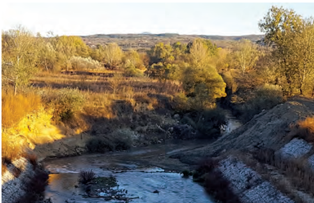
Slika 8. Krajnja - nizvodna deonica ispod mosta na kraju ukupne deonice, projektovana za izvođenje zaštite; zaštita boka Autoputa E-75
