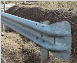
Klasični "riblji rep" probada karoseriju i prouzrokuje nepredvidive posledice kod prodora elemenata ograde kroz putničku kabinu
