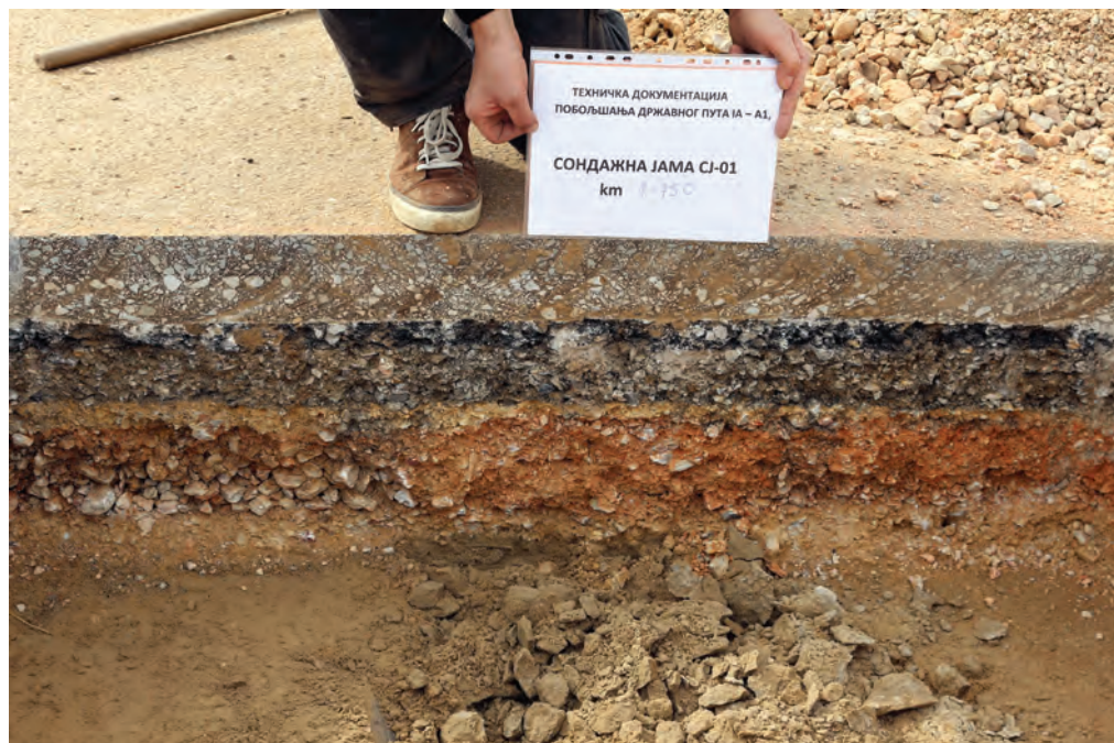
Slika 3. Profil kolovozne konstrukcije u sondažnoj jami
