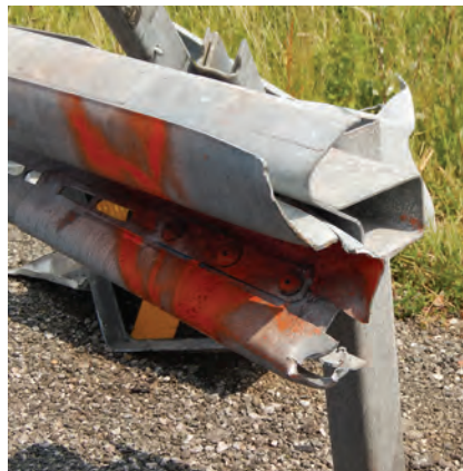
Štrčeći i odlomljeni elementi lako probadaju karoseriju
