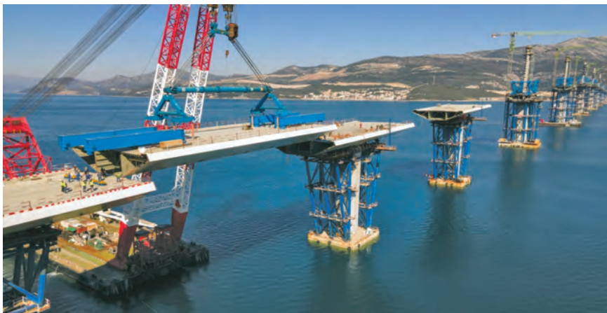
Ugradnja segmenta pristupnog dijela mosta, mase 520 tona (ožujak 2021)
