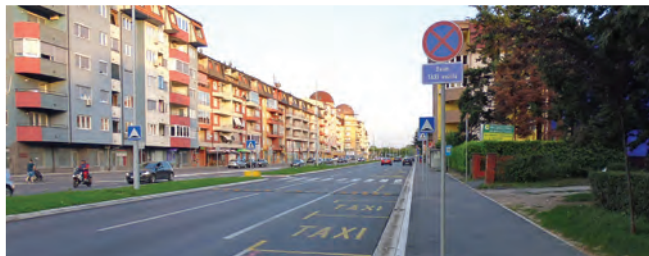
Izvedena rekonstrukcija ulice Bulevar Mira u Brčkom. Projekat izvedenog stanja: Planinvest d.o.o. Brčko
