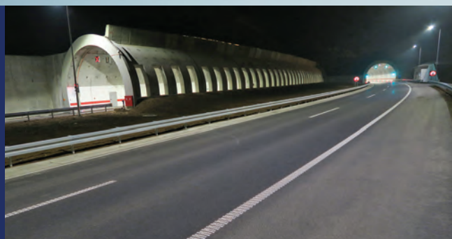
Projekat: Tunel Šarani, auto-put E 763, Beograd - Južni Jadran, deonica III: Takovo - Preljina Usluga: Izgradnja dve paralelne tunelske cevi dužine 883 m i 887 m Investitor: Koridori Srbije d.o.o. / Azvirt LLC - Azvirt ogranak, Beograd
