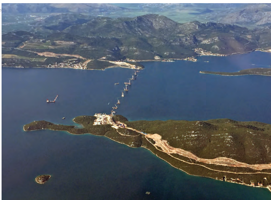
Gradilište mosta Pelješac (lipanj 2020)
