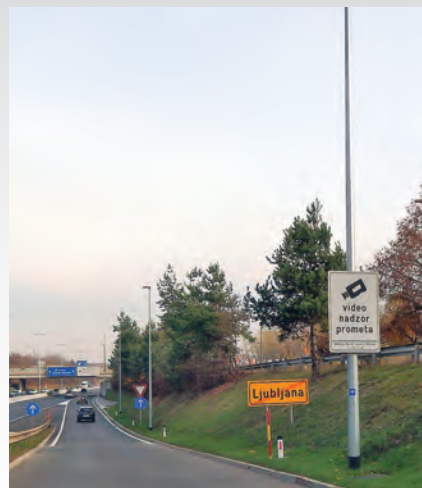
Svi ZIP stubovi prikazani na fotografijama imaju karakteristike 100-HE-C-S(R)-NS-MD-1 po novom izdanju norme EN 12767:2019
