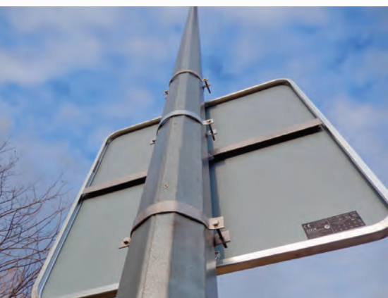
Na ZIP stub se mogu montirati i razne table, kamere ili drugi sistemi za nadzor saobraćaja
