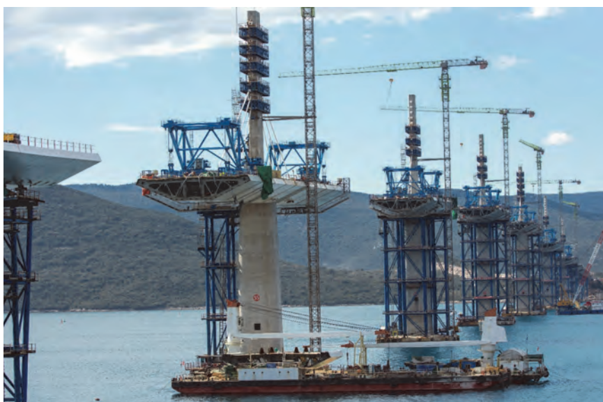
Ugradnja segmenta pristupnog dijela mosta, mase 520 tona (ožujak 2021)
