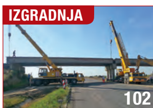
IZGRADNJA Obilaznica oko Subotice "Y krak" 102
