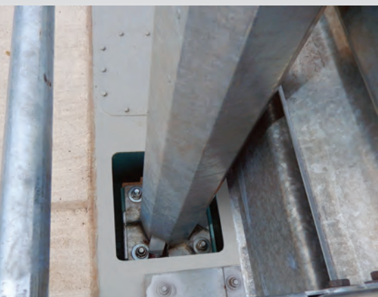
Montaža na mostovnoj konstrukciji - podloga tip R (po novoj normi EN 12767:2019)
