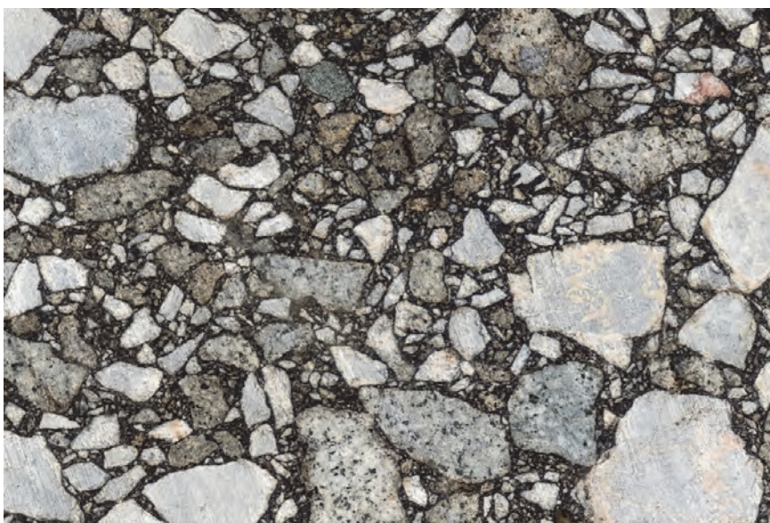
Slika 2. Asfaltna mešavina za izradu nosećih slojeva sa 50% struganog asfalta (BNS 22sA/AC 22 BASE)
