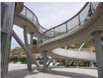
Pasarela Beograd - tehnički pregled
