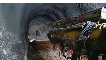
Proboj dovodnog tunela za hidroelektranu "Dabar" (Nevesinje, BiH)
