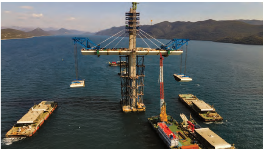
Podizanje čeličnih segmenata na stupu S8, mase po 170 tona (ožujak 2021)
