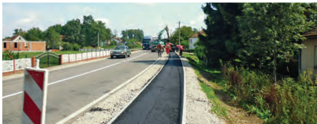
Izgradnja pješačke staze uz regionalni put u MZ Tišina. Investitor: Opština Šamac; projektant: Planinvest d.o.o. Brčko; nadzor: Miodrag Simić
