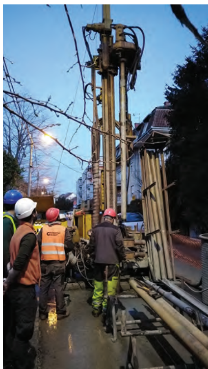
Garnitura za bušenje na terenu - trasa metro linije 1
