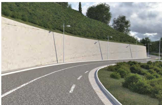
Potporni zid na pristupnoj rampi kod Denivelisane raskrsnice 1
