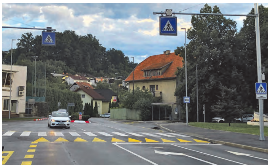
Pešački prelaz ispred škole na podignutoj platformi, sa trepćućim svetlima i saobraćajnim znakom iznad kolovoza
