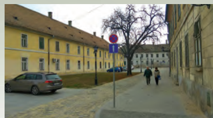
Podgrađe Petrovaradinske tvrđave - uređenje ulice Prote Mihaldžića
