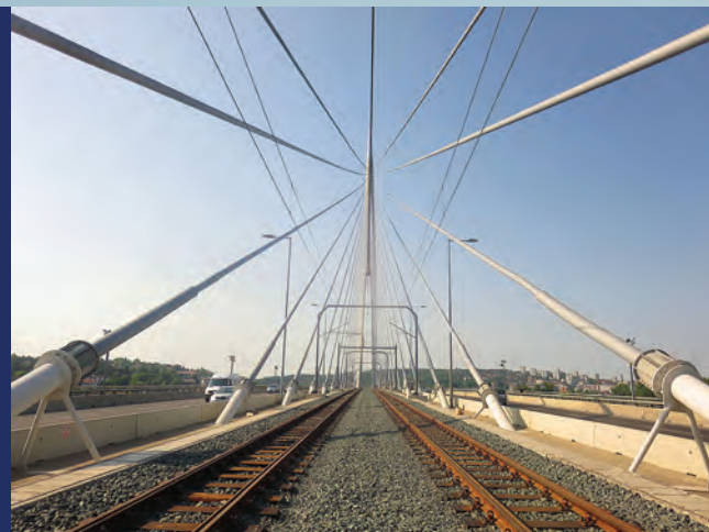
Projekat: Izvođenje tramvajske pruge na mostu na Adi Usluga: Izvođenje radova Investitor: Gradska uprava grada Beograda
