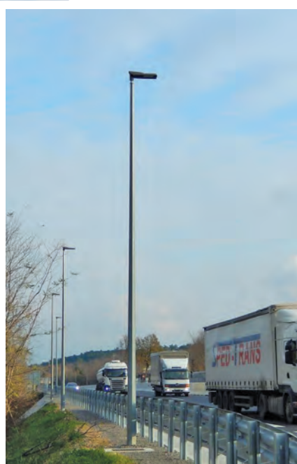
Stub u radnoj širini ograde mora biti pasivno bezbedan
