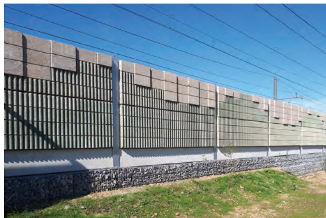
Betonski/drveno-betonski PHONOBLOC® paneli za železnice (Barijera protiv buke Maribor - Slovenske Železnice)
