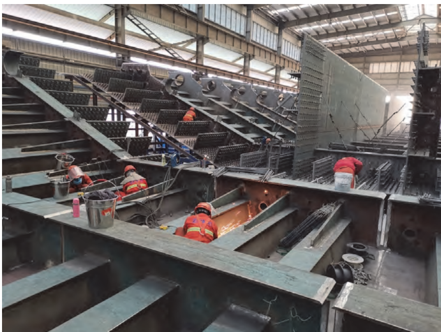
Zavarivanje odsječaka rasponskog sklopa mosta Pelješac u kineskoj tvornici: limovi s moždanicima bit će ubetonirani u stup
