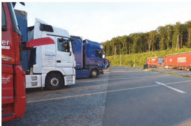
Slika 17. Površine parkirališta za putnička i teretna vozila izvedene kaldrmisanjem granitnom kockom, izvor: K. Hrapović
