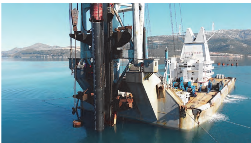
Zabijanje pilota - čeličnih cijevi koje čine donji dio temelja mosta
