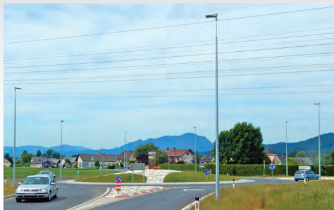
Ne samo prvi na ulazu; svi stubovi u kružnoj raskrsnici moraju biti pasivno bezbedni
