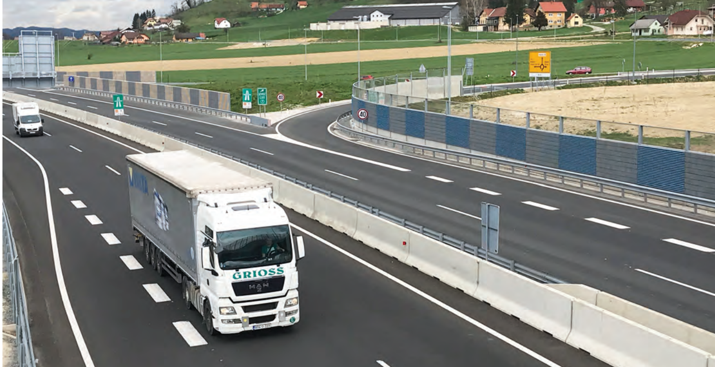
DELTABLOC® bezbednosne ograde i PHONOBLOC® barijere protiv buke na AC A4 Slivnica-Gruškovje
