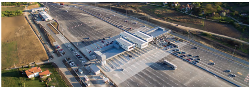
Naplatna stanica Vrčin - projektovanje, nadzor
