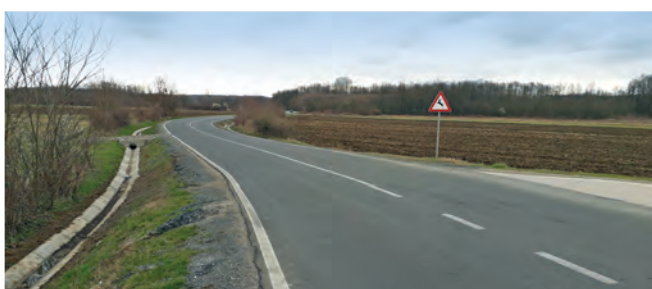
Izvedena sanacija puta R460 Skakava po projektu Planinvest d.o.o. Brčko
