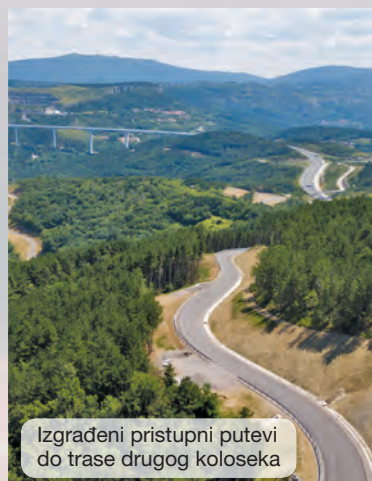
Izgrađeni pristupni putevi do trase drugog koloseka
