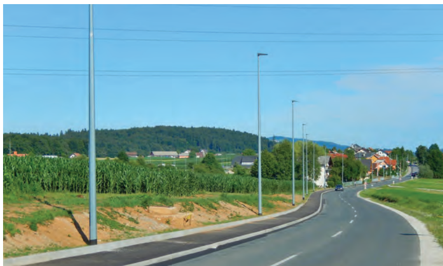
Ivičnjak trotoara ne sprečava prelaz vozila, pa stubovi treba da budu pasivno bezbedni
