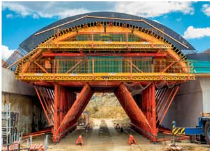
Korišćenje hidraulike prilikom premeštanja oplatnih kolica čini tunnelsku konstrukciju posebno ekonomičnom.
