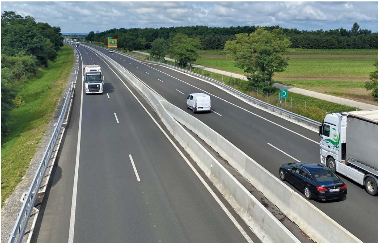
Betonske zaštitne ograde DELTABLOC® osiguravaju najveću moguću bezbednost nivoa H4b prema važećim standardima EN 1317. Auto-put AC H5 Murska Sobota-Maribor, izvedeno 16 km H4b betonskih zaštitnih ograda visine 120 cm. Investitor: DARS d.d.
