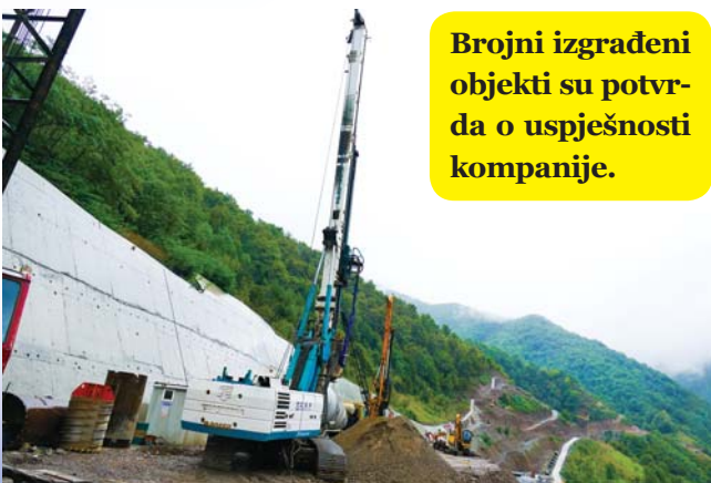
Bušenje šipova mašinom Casagrande, Koridor Vc
