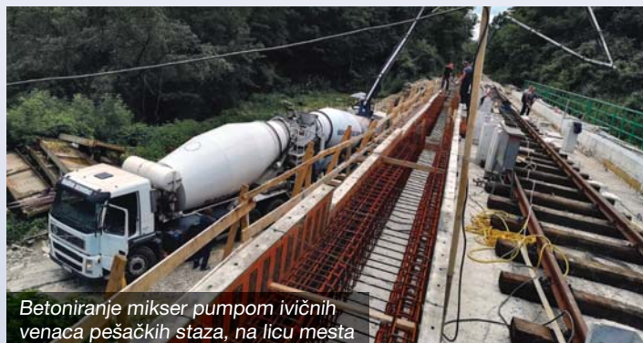
Izvedeni gornji stroj pruge u železničkoj stanici Mala Krsna
