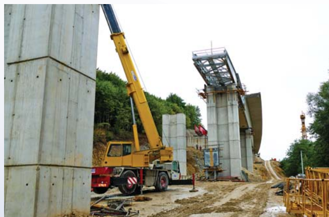
Gradnja mosta tehnologijom postepenog naguravanja
