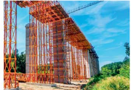
ALPHAKIT nosivi tornjevi i rešetkasti nosači primenjeni na izgradnji vijadukta Čortanovci.
