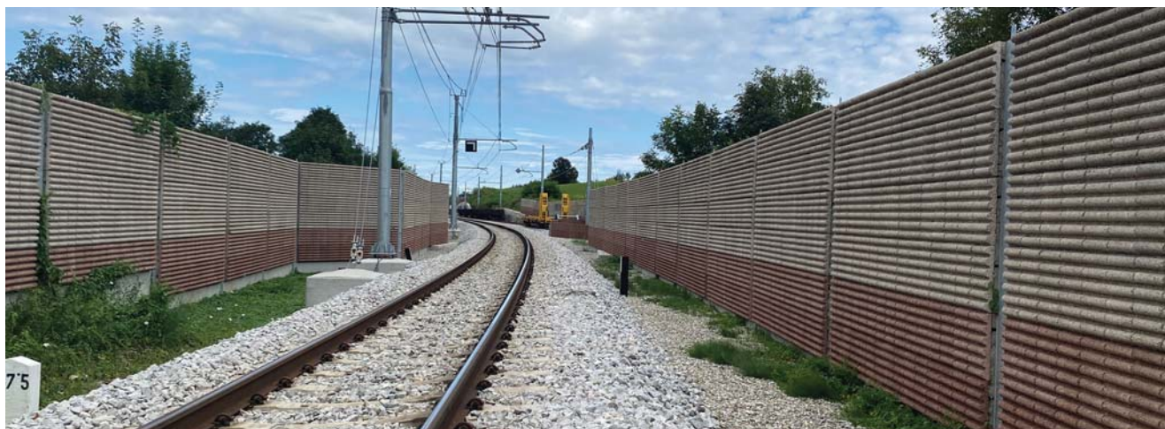
Betonski/drveno betonski PHONOBLOC® paneli protiv buke na železničkoj pruzi Maribor-Šentilj-granica sa Austrijom. Izvedeno oko 10 km, 20.000 m 2 betonskih/drvo betonskih barijera za buku. Investitor: DRSI/Slovenske Železnice.
