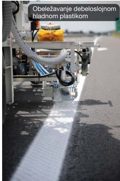
Auto-put E-75, Subotica - Novi Sad, obeležavanje horizontalne signalizacije
