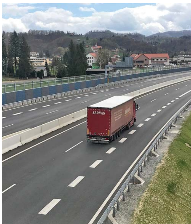
DELTABLOC® betonske zaštitne ograde i PHONOBLOC® barijere protiv buke izvedene na auto-putu AC A4 Maribor-Gruškovje-Zagreb. Izvedeno 17 km betonskih zaštitnih ograda, 40.000 m 2 betonskih/drvo betonskih barijera za buku i 3.000 m 2 transparentnih barijera za buku. Investitor: DARS d.d.
