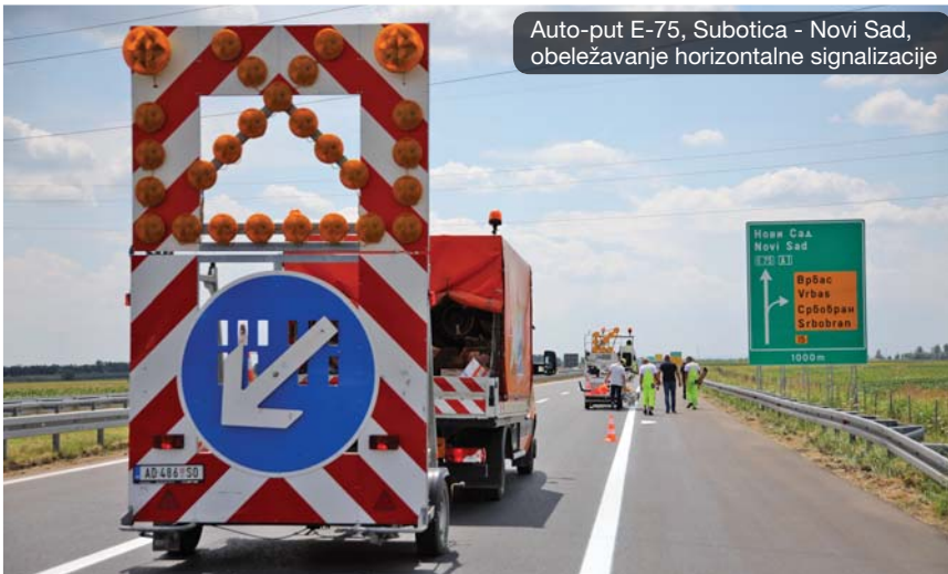
Obeležavanje debeloslojnom hladnom plastikom
