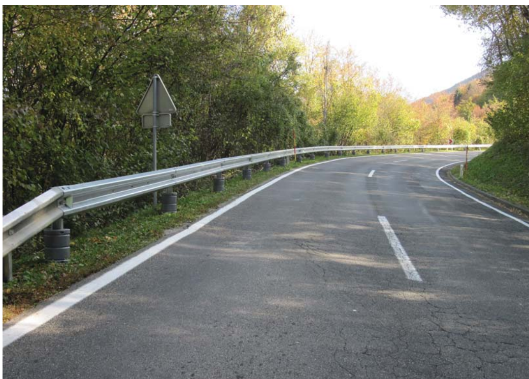
Slika 4. Pravilna izvedba UUM i gabaritne mere za zaštitu stupa čelične zaštitne ograde; autor fotografije B. Matko
