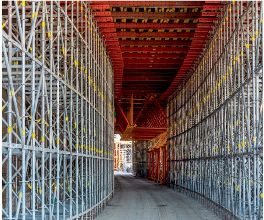
ALPHAKIT modularna nosiva skela u kombinaciji sa PERI UP Flex tornjevima za podupiranje prilikom realizacije projekta nove železničke stanice Beograd Centar.
