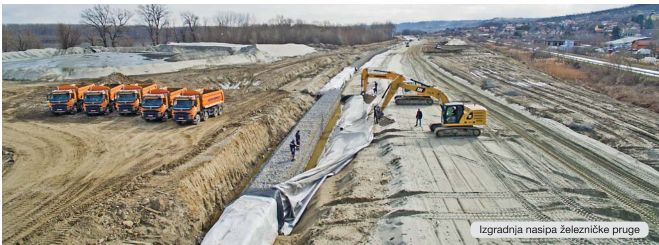
Nasip železničke pruge
