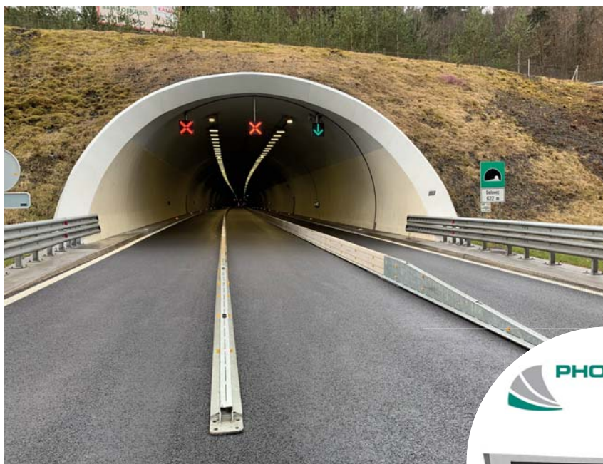
Privremene betonske zaštitne ograde tipa DELTABLOC SB 50. Izvedeno 5 km ograda za obezbeđivanje radova i saobraćaja pri obnovi tunela Golovec. Investitor: DARS d.d.
