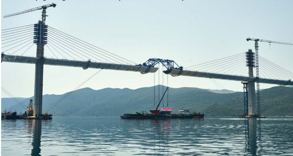
Povezivanje glavnog nosača Mosta Pelješac u kontinuiranu cjelinu
