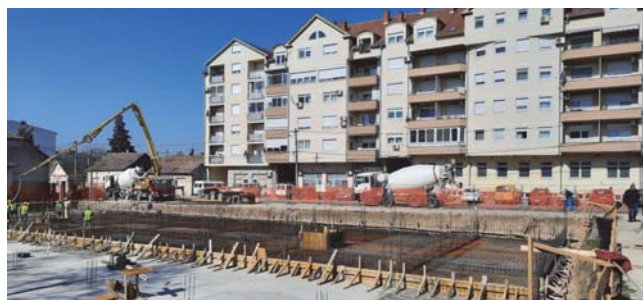
Betoniranje temeljne ploče, nadzor: Šidprojekt d.o.o.
