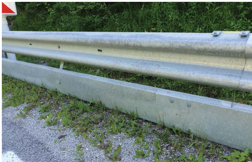
Slika 3. Pravilna izvedba ML i gabaritne mere (prikaz branika je simboličan); autor fotografije T. Tollazzi
