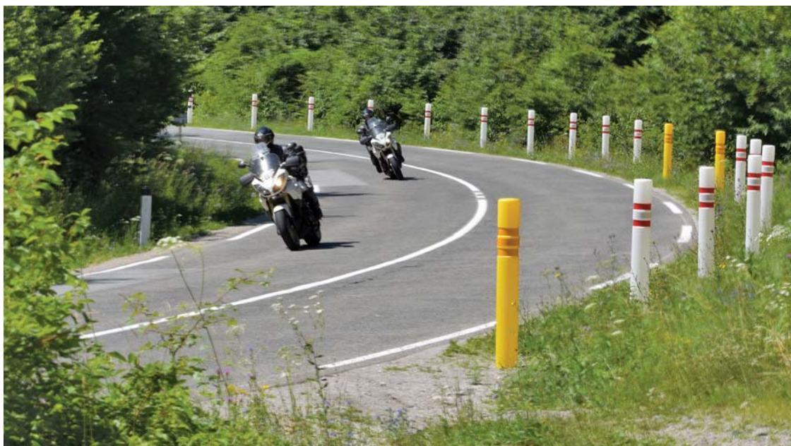
Slika 5. Pravilna izvedba PBS i gabaritne mere; autor fotografije T. Polenšak
