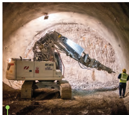
Radovi na iskopavanju u tunelu Beka (T2)
