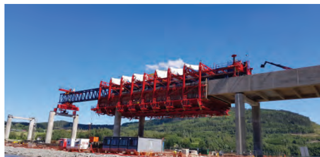
Slika 11. Primena sistema pokretnih skela (MSS)
