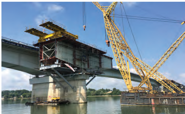
Slika 2. Montaža konstrukcije mosta preko Save kod Ostružnice - STRABAG, MOSTOGRADNJA
