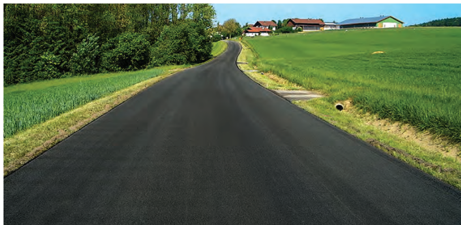
Primer ugradnje AC Duopave/Kleinmünchen PAN 38
