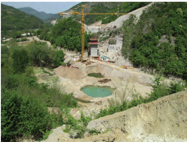
Sl. 7 Temelj stuba za most preko Kozničke reke - LOT 5
