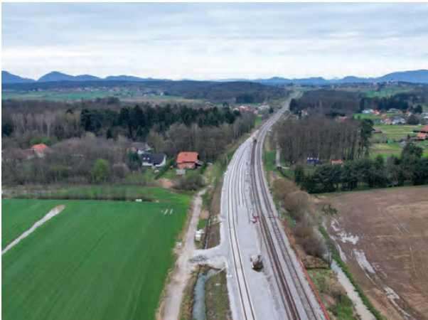
Slika 5: Izgrađeni provizorij na področju podvoza
