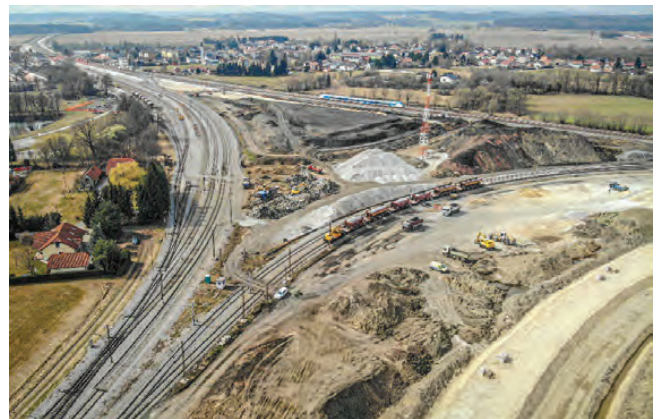
Slika 2: Čvor tokom izvođenja radova
