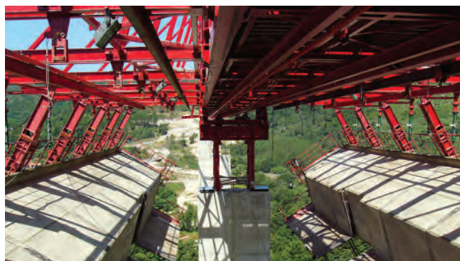
Slika 13. Overhead MSS nosač
