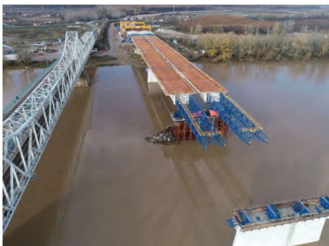
Slika 6. Inkrementalno lansiranje (ILM) čeličnog mosta preko Save kod Sremske Rače - TASYAPI
