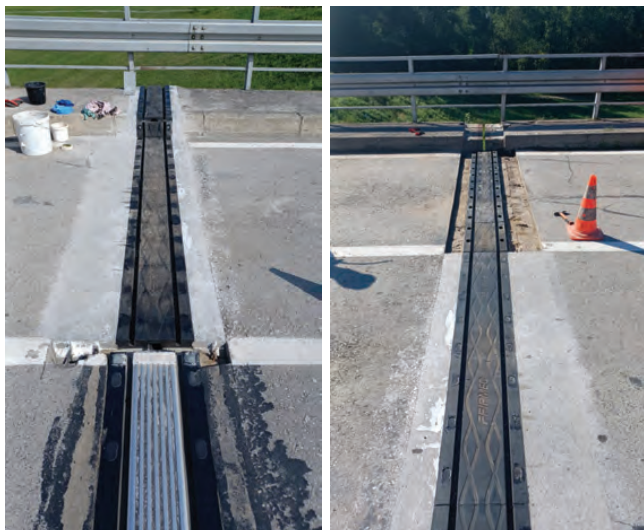
Elastomerna prijelazna naprava
