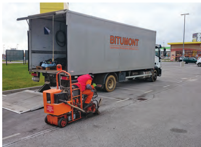
Sanacija pukotina u asfaltu
