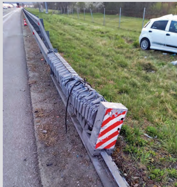
Slike 9 i 10. Nakon udara u levu ogradu vozilo proklizava bočno, udara u početnu konstrukciju i završava u neposrednoj blizini na zelenom pojasu.
