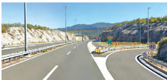
Slika 5: Ublaživač je postavljen tako da zatvara traku za zaustavljanje iako ima mesta da se pomeri više paralelno prema liniji glavnog pravca kretanja vozila. Ovako postavljen kao da govori „udari me“.
