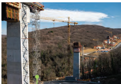
Izgradnja Vinjanskog vijadukta
