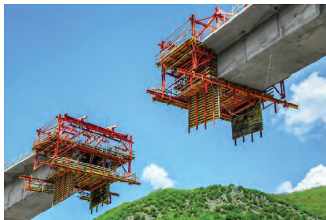
Slika 8. Metoda balansirane konzolne gradnje (BCM) - putujuće oplata
