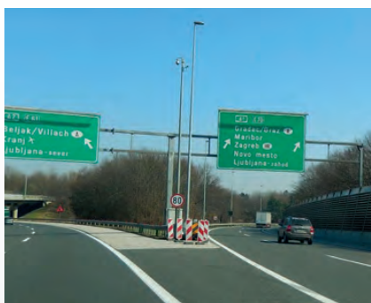
Slike 1 i 2: Čvorište na auto-putu oko Ljubljane. Prilaz iz pravca Postojne i isto čvorište iz pravca Zagreba - često „gađani“ ublaživači udara.
