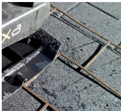
Matrica za štampanje asfalta i njegovo izvođenje
