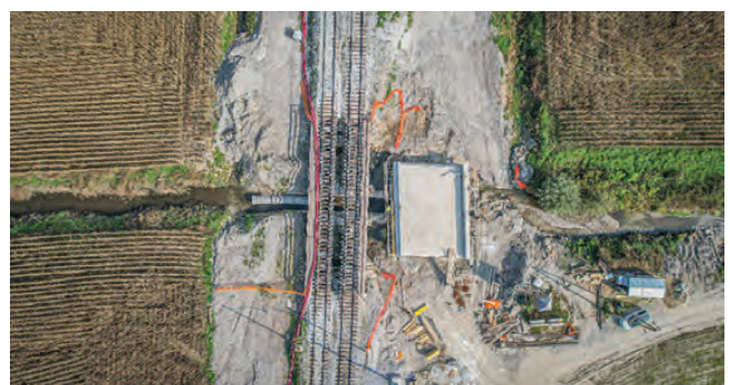
Slika 4: Provizorij na početku radova
