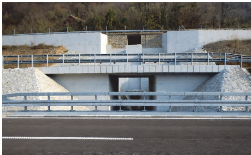
Slika 6. Pogled uz Selišku dolinu, položaj objekata za propuštanje potoka kroz trup magistralnog puta M1, duboko okno i trup jedne trake auto-puta
