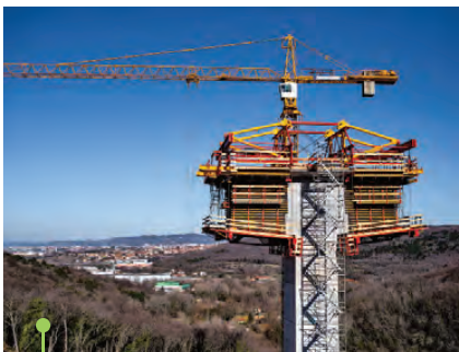
Na Vinjanskom vijaduktu postavlja se oplata za rasponsku konstrukciju sa obe strane stuba
