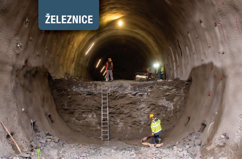
Iskop i podupiranje stepenice sa podnožnim svodom u tunelu Beka (T2)
