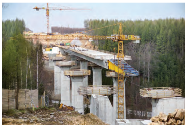
Slika 5. Inkrementalno lansiranje (ILM) betonskog mosta sandučastog poprečnog preseka
