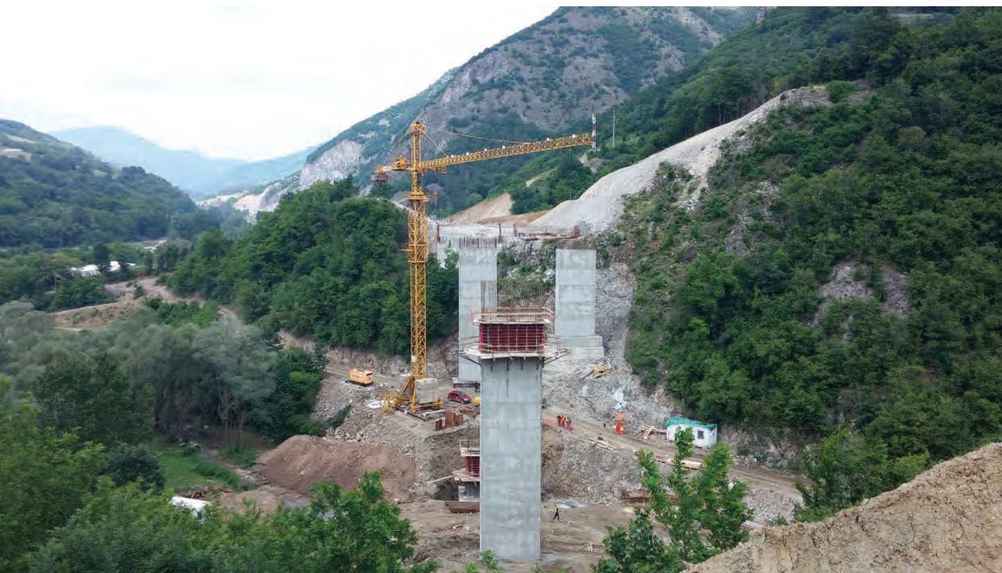
Sl. 6 Temelj stuba za most preko Kozničke reke - LOT 5
