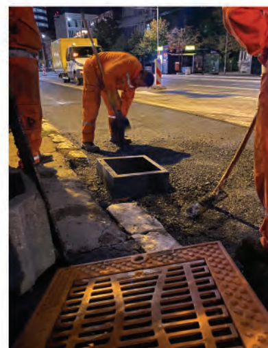
Ugradnja novih inovativnih slivnih rešetki u ulici Kneza Miloša
