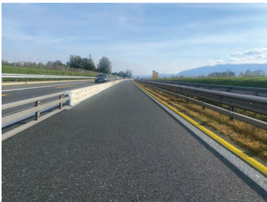
Privremene ograde za gradilišta na auto-putu A2 Kranj-Jesenice. Izvedeno 13 km privremenih ograda kombinacije betonske ograde DELTABLOC SB 50 i čelične ograde DELTABLOC STEEL PRO 500. Investitor: DARS d.d.
