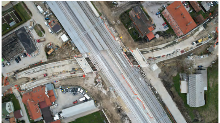
Slika 8: Področje podvoza na završetku radova na šinama
