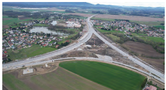
Slika 3: Čvor na završetku radova
