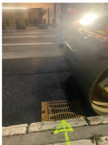
Ugradnja novih inovativnih slivnih rešetki u ulici Kneza Miloša
