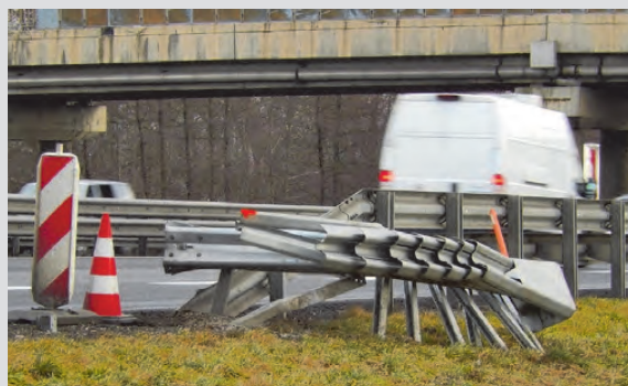
Slika 8. Početna konstrukcija koja je zakazala zbog nedorađenog sistema.
