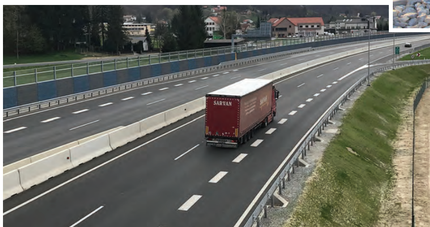
DELTABLOC® betonske zaštitne ograde nivoa zadržavanja H4b i PHONOBLOC® barijere protiv buke izvedene na auto-putu AC A4 Maribor-Gruškovje-Zagreb. Izvedeno 17 km betonskih zaštitnih ograda, 40.000 m 2 betonskih/drvo betonskih barijera za buku i 3.000 m 2 transparentnih barijera za buku. Investitor: DARS d.d.
