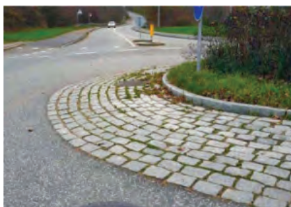
Nagazni dio kružnog ostrva
