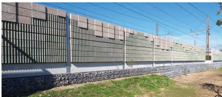
Betonski/drveno betonski PHONOBLOC® paneli za željeznice (barijera protiv buke na željezničkoj pruzi Maribor-Hoče-Rače). Izvedeno oko 1 km. Investitor: DRSI.
