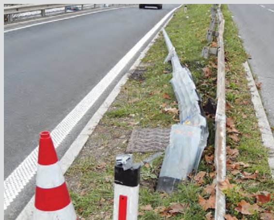
Slika 1. Oboren pasivno bezbedan ZIP stub je spasio život, samo je materijalna šteta bila u pitanju.
