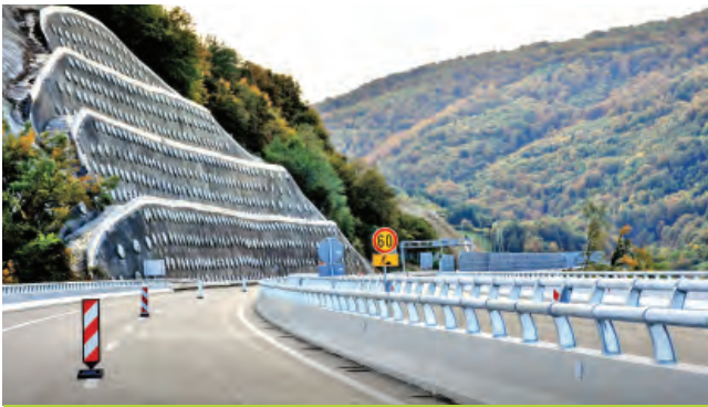
Autocesta na Koridoru Vc, dionica: Tarčin-Konjic, poddionica: Tarčin-Ivan (zaštita kosina)
