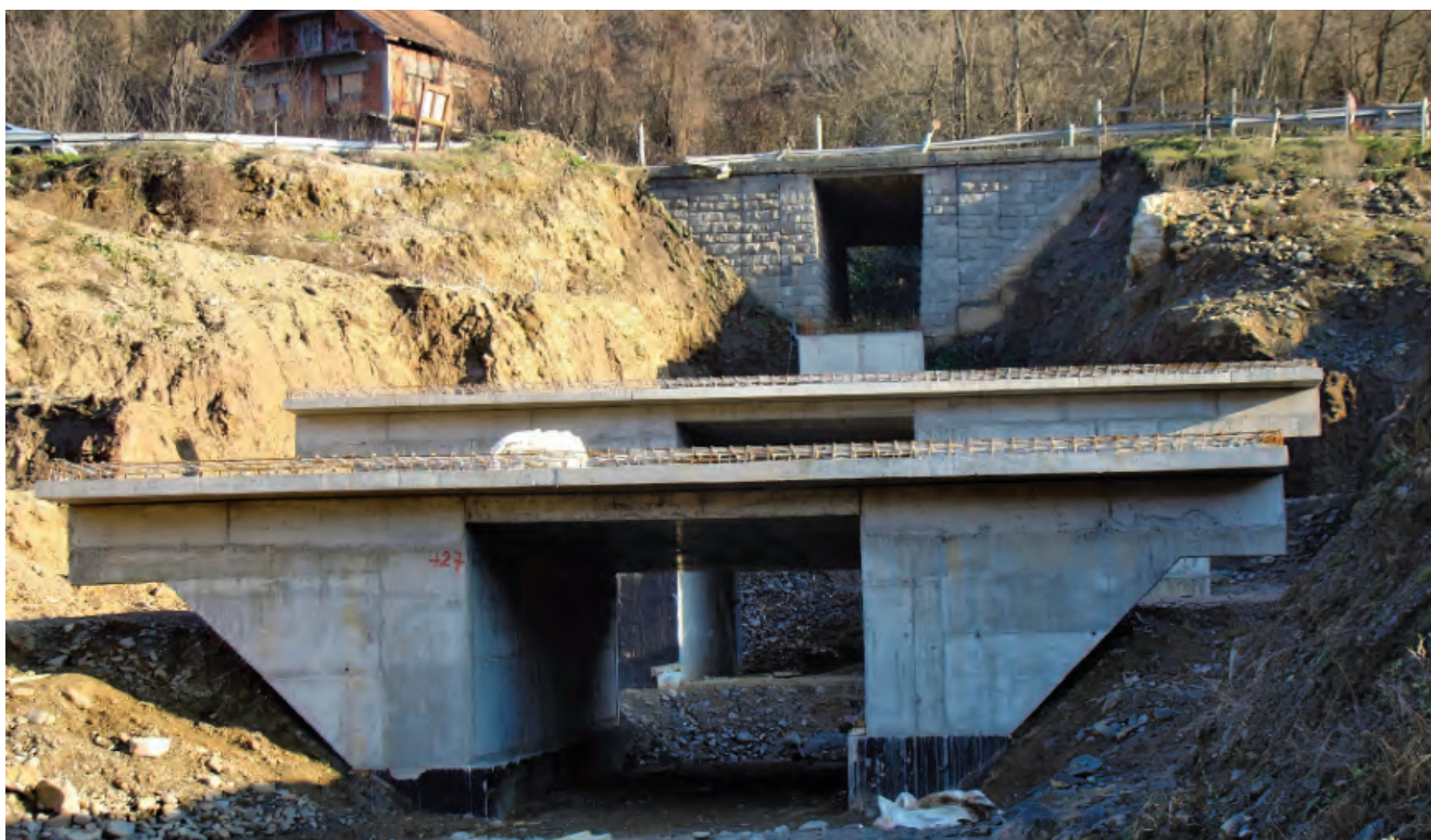
Slika 5. Pogled uzvodno na Selišku dolinu i položaj objekata za propuštanje potoka kroz trup magistralnog puta M1, i potom kroz trup jedne i druge trake auto-puta pre početka izrade nasipa obe trake auto-puta.
