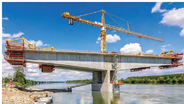
Slika 1. Balansirana konzolna gradnja, most preko Save kod Šapca - AZVIRT; Form Traveller System - PERI
