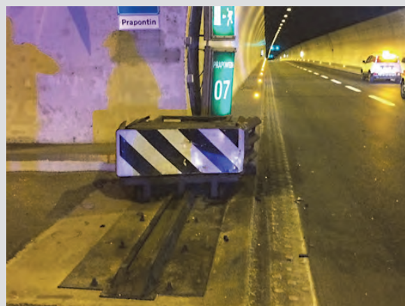
Slika 6. Apsorber, koji je kategorisan za 80 km/h pokazao se dobrim i za veću brzinu. Posebno još na skućenom prostoru kao što je tunel, karakteristike Z1 i D1 su bitne, da bi posledice udara bile što manje. U ovom slučaju vozač je prošao čak bez ogrebotina.
