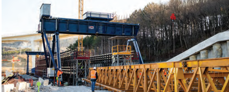
Radionica na vijaduktu Gabrovica, gde se betoniraju rasponski delovi vijadukta koji se kasnije guraju preko stubova
