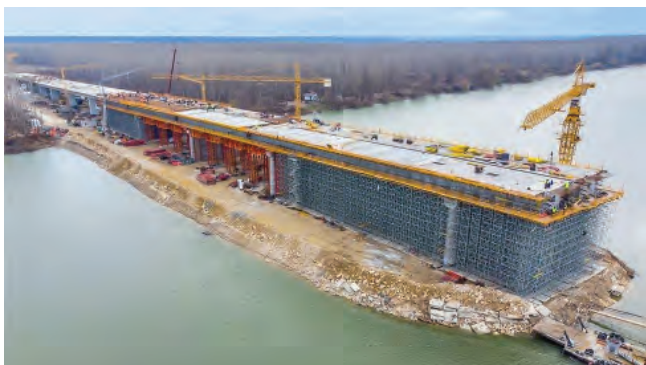
Slika 4. Izgradnja prilaznih raspona, most preko Save kod Šapca - AZVIRT; skela PERI
