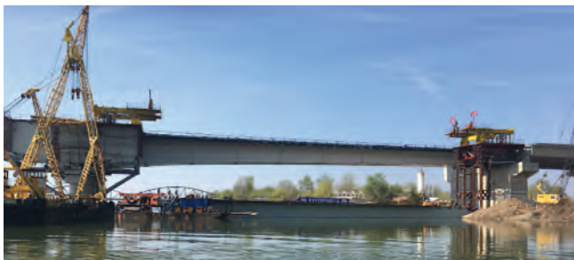
Slika 3. Podizanje celog raspona mosta prethodno pretvorenog u plovilo, iz vode (Most preko Save kod Ostružnice - STRABAG, MOSTOGRADNJA)
