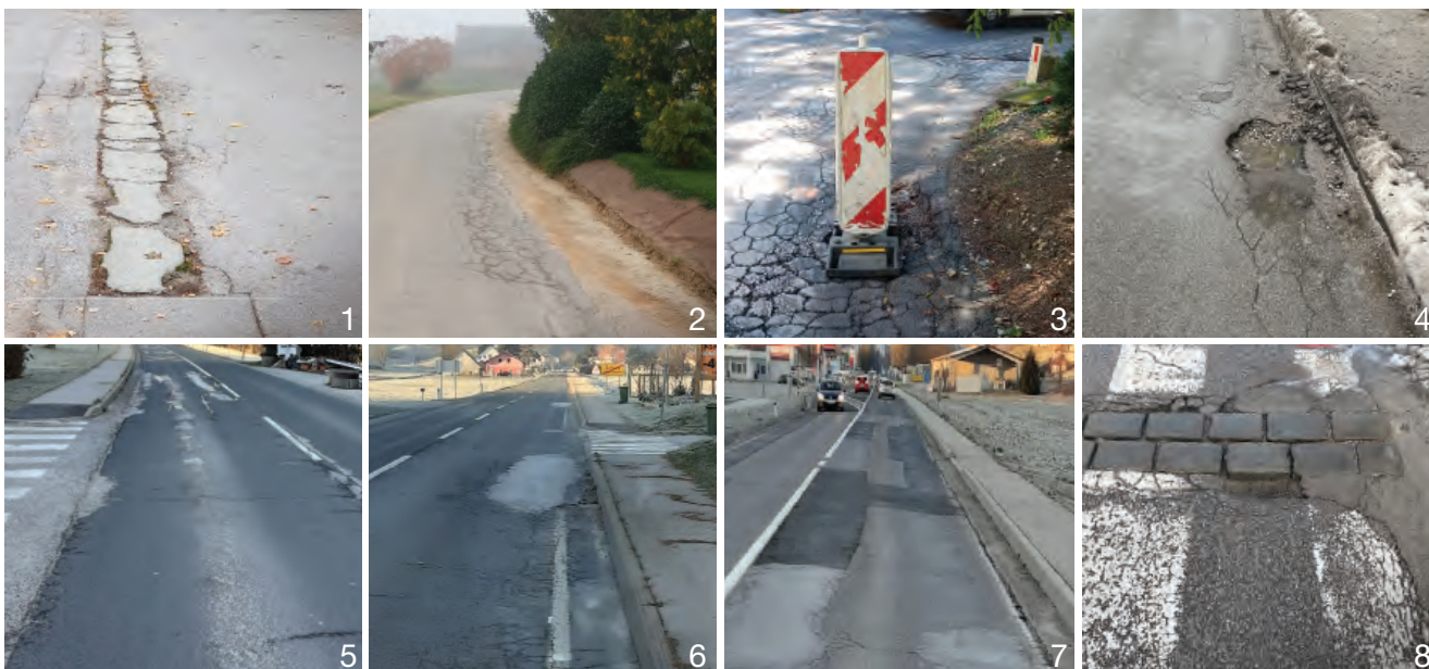
Slika 5: Primeri oštećenja i drugih nepravilnosti koje otežavaju vožnju e-skutera
