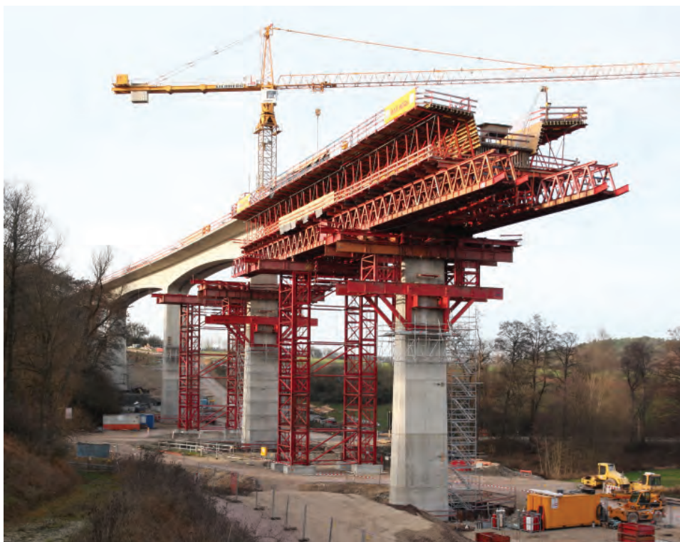
Slika 12. Underslung MSS nosači
