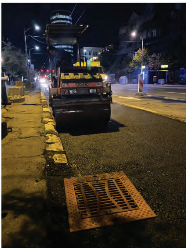
Ugradnja novih inovativnih slivnih rešetki u ulici Kneza Miloša
