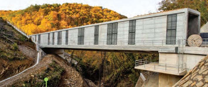
Vijadukt Glinščica koji povezuje prvi i drugi tunel na trasi drugog koloseka, već je izgrađen
